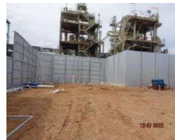
การติดตั้งรั้วขอบเขตพื้นที่ก่อสร้าง
